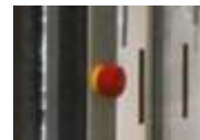
Botón de parada de emergencia: Detiene inmediatamente la puerta en caso de peligro, desconectando la corriente. La puerta queda en modo manual.
