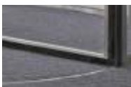
Cepillo de estanqueidad: En la parte superior, inferior y borde delantero de la hoja de la puerta.
